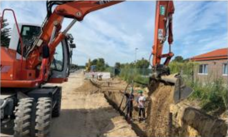
Baugrabenverfüllung mit Bodenmaterial von der Bereitstellungsfäche
