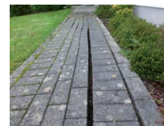
Geschädigte Wegedecke durch Baugrundsetzungen (FLL)
