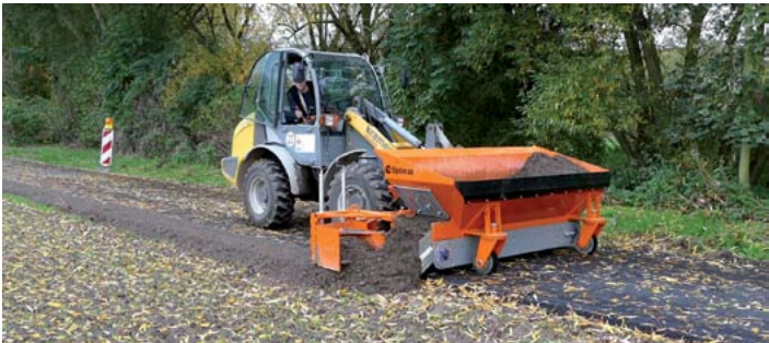
Das Anbaugerät „Finliner“ von Optimas – die günstige Alternative zum Bankettfertiger.
