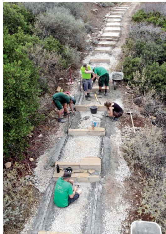
Zusätzlich wurde der Bau eines botanischen Weges fortgesetzt, der bereits im Jahr 2018 begonnen wurde. Entlang dieses Weges entstanden nicht nur Treppenanlagen, sondern auch kreative Bodenmosaiken und Säulen für einen zauberhaften Laubengang.
