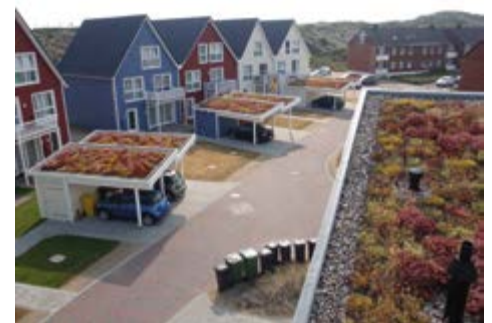
Pflanzen auf dünn-schichtigen Dachbegrünungen leiden oft unter Wassermangel. Die re-natur Wasserspeichergranulate verbessern die Wasserversorgung langfristig und sorgen für kräftige und gesunde Dachstauden.
